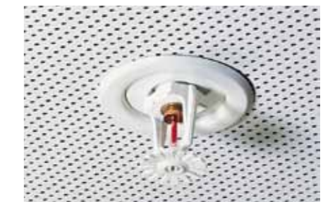
Dairesel kesimli deliğe, Sprinkler kolayca monte edilir.
